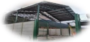
Instalación de almacenes
